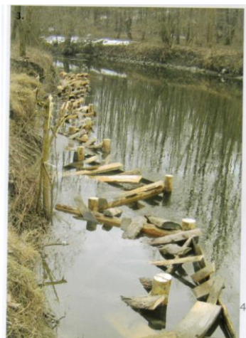
Figura 7. Diversivo del flusso idrico con materiale vegetale reperito in loco (Foto S. Salviati).
