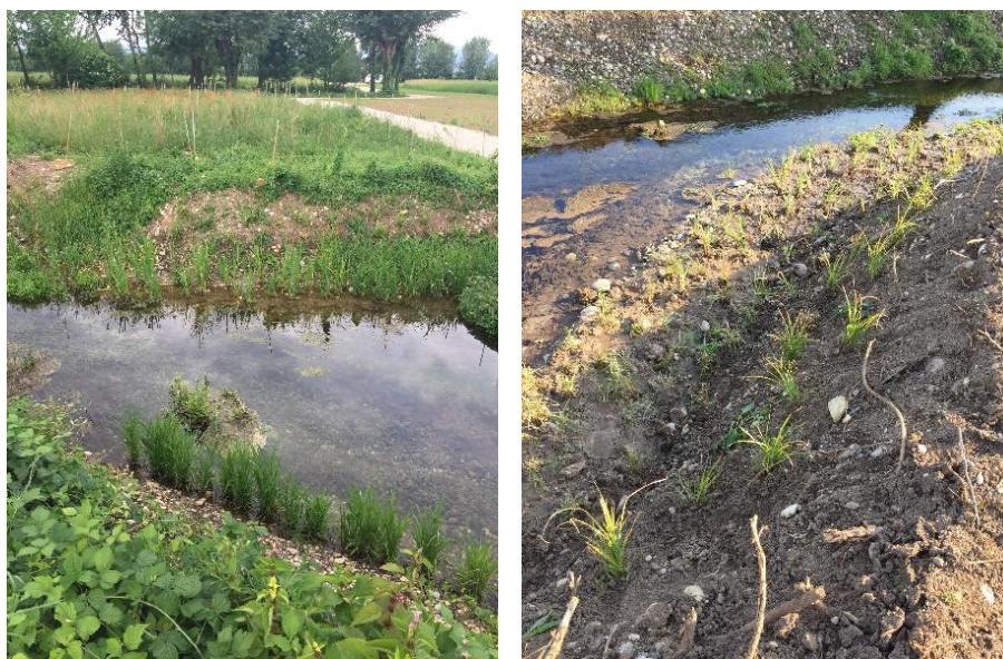
Foto 13. Esempio senza allargamento del corso d'acqua (Foto R. Fiorentin).
