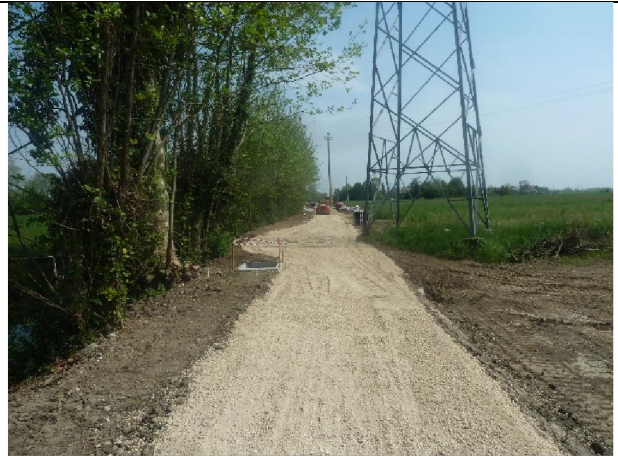
Realizzazione tubi sotto strada per consentire l'uscita dell'acqua dalla canaletta per l'irrigazione
