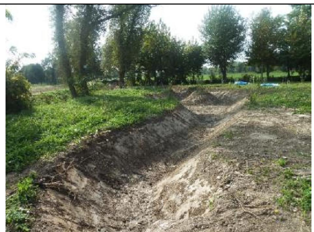
Realizzazione area di fitodepurazione capofonte (non previsto)
