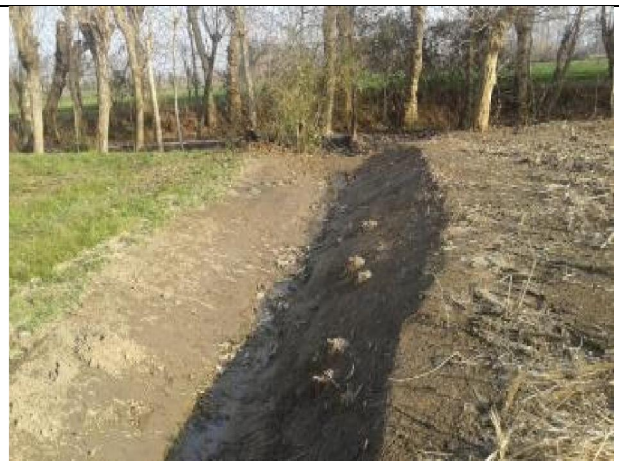
Creazione area di fitodepurazione
