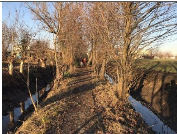
CR10. Rimozione sedimenti e riprofilatura alveo su entrambe le canalette e ripristino i flussi e pendenze
