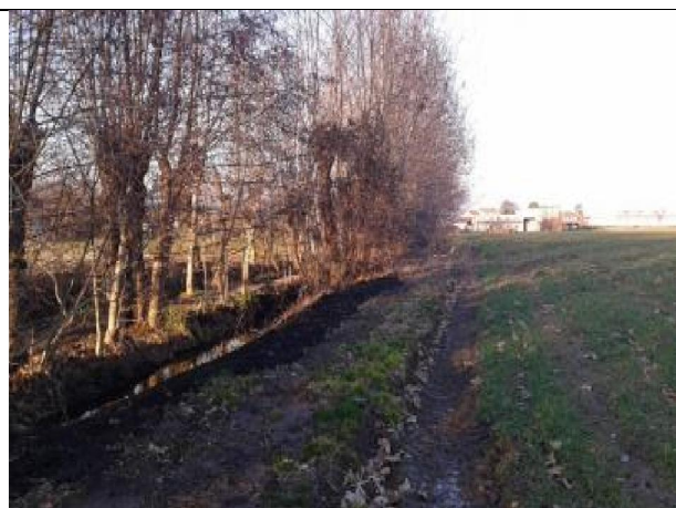
Sistemazione sostegno della sponda
