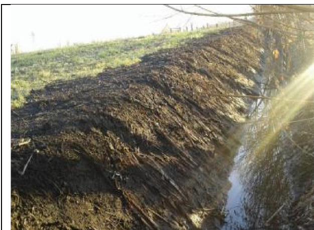
Sistemazione sostegno della sponda
