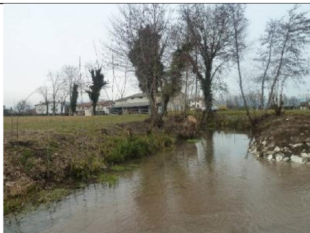
Sistemazione zona con addolcimento sponda
