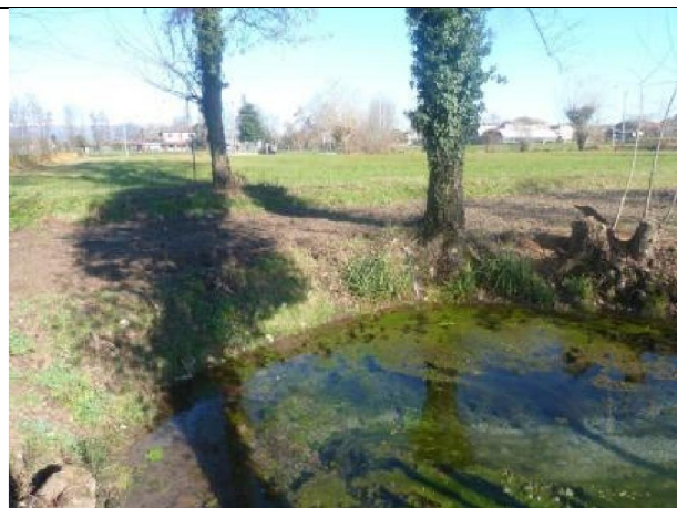
CR29. Sistemazione sponde della testa di risorgiva
