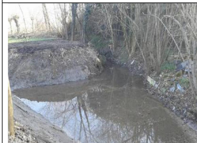
CR20. Riapertura capofonte (dopo lavori)
