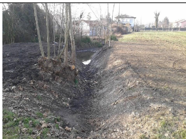
CR20. Riprofilatura asta con sistemazione
