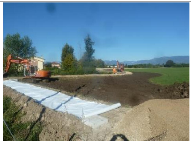
Percorso pedonale (durante lavori)
