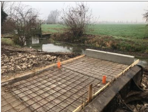
Ponte piano accesso a nord
