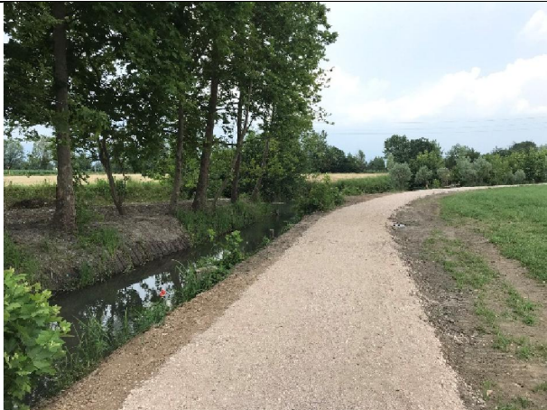
Percorso pedonale (fine lavori)
