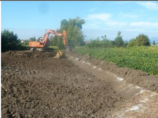
intervento di riprofilatura e abbassamento sponda con creazione di zona umida
