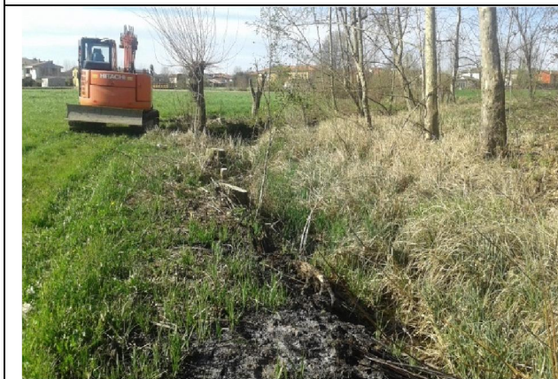
Percorso pedonale (prima dei lavori)
