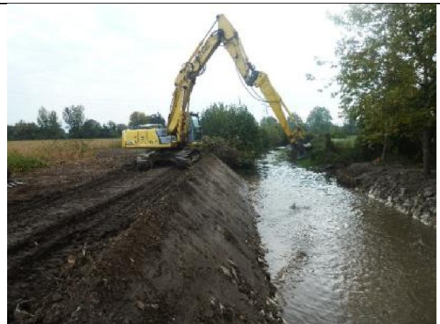
CR32. Rimozione sedimenti e riprofilatura alveo
