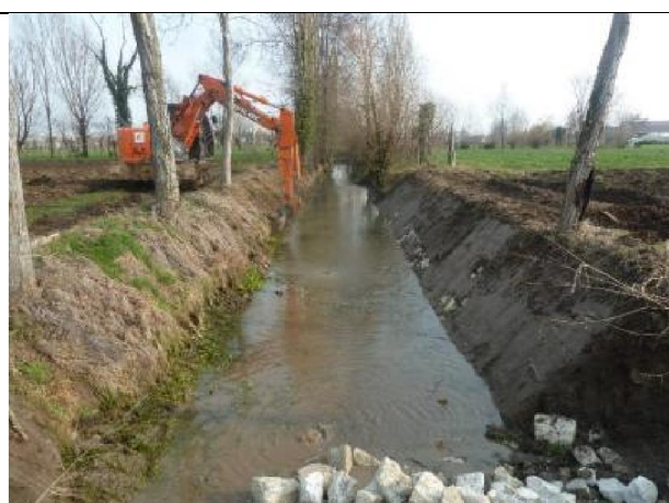
CR09. Rimozione sedimenti e riprofilatura alveo su entrambe le sponde
