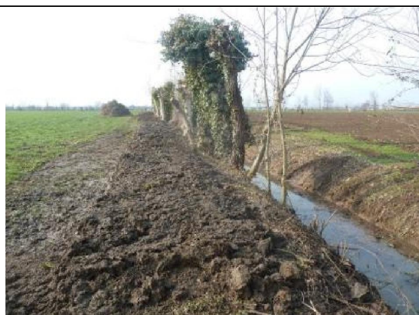
CR06-07-08. Sistemazione spondale su entrambe le sponde - dopo
