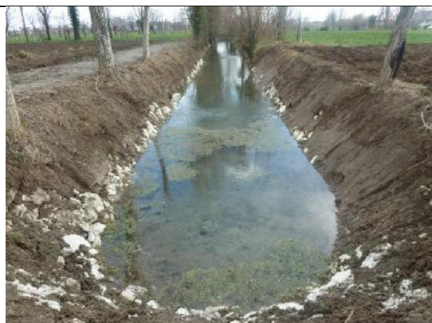
CR09. Sistemazione spondale su entrambe le sponde
