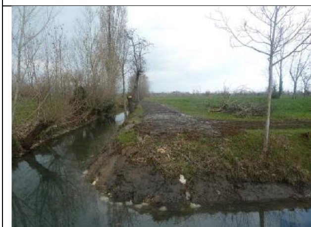
Spurgo e sistemazione spondale su entrambe le sponde
