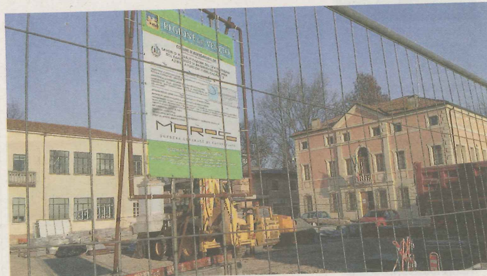
I lavori per realizzare la nuova piazza nel centro di Bressanvido. FOTO FRISON
